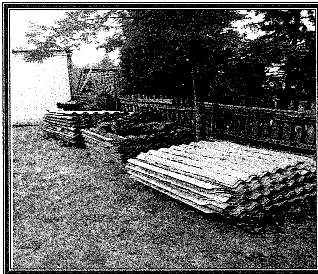
Rys. 11. Azbest pochodzący z budynku gospodarczego zlokalizowanego w m. Czaple, przygotowywany do zabezpieczenia i utylizacji (źródło: Urząd Miejski w Świeciu).
